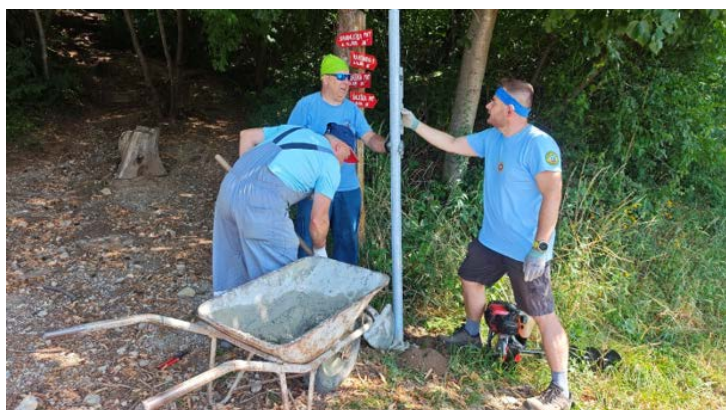
Delovna akcija – betoniranje drogov usmerjevalnih tabel
