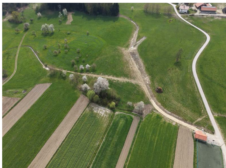
Sanacija odvodnjavanja v Slatinah pri igrišču
